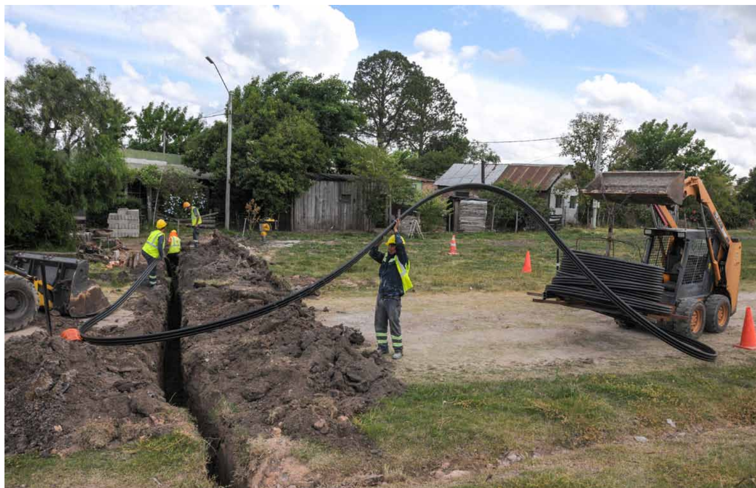
Obras de conexión de fibra óptica
